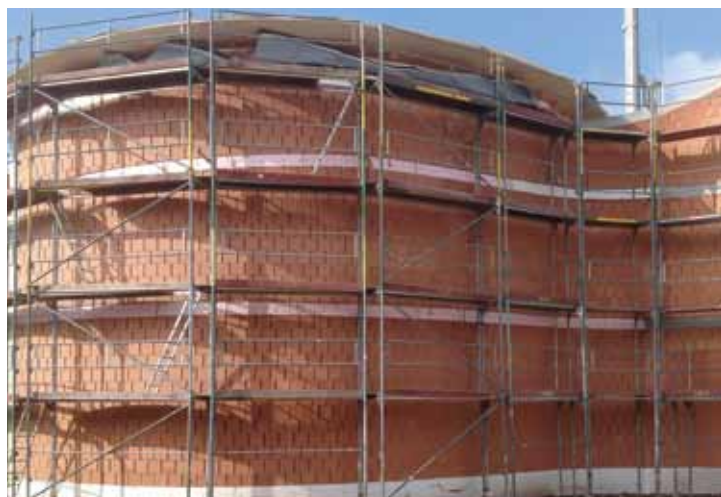
An den stärksten Rundungen der Außenwände erreichen die Fugen eine Breite von 8–10 cm.
