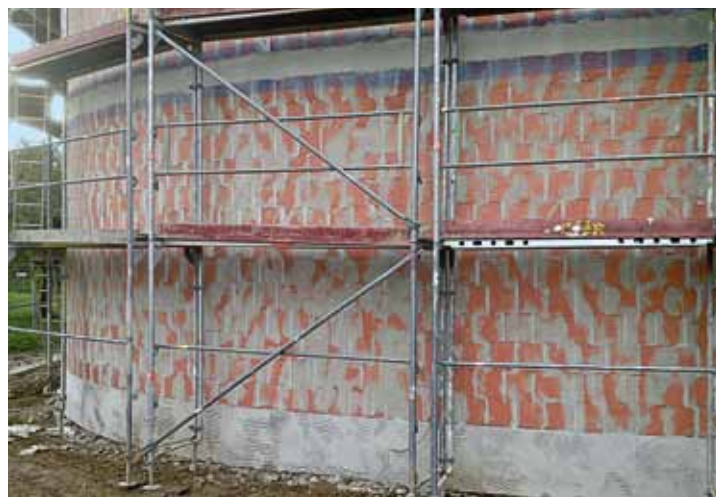
Jede Fuge wird einzeln und vollständig mit dem quick-mix Dämmputz DP-B maschinell verfüllt.
