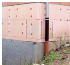
Mauerwerk (Sockel gedämmt)
