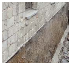
Mauerwerk (Sockel ungedämmt)
