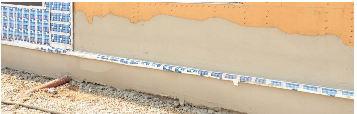
Mauerwerk (Sockel ungedämmt)
