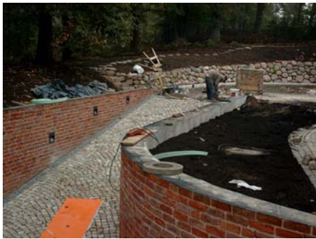
Bildzeile: Schritt für Schritt wird das Natursteinpflaster auf die Auffahrt verlegt
