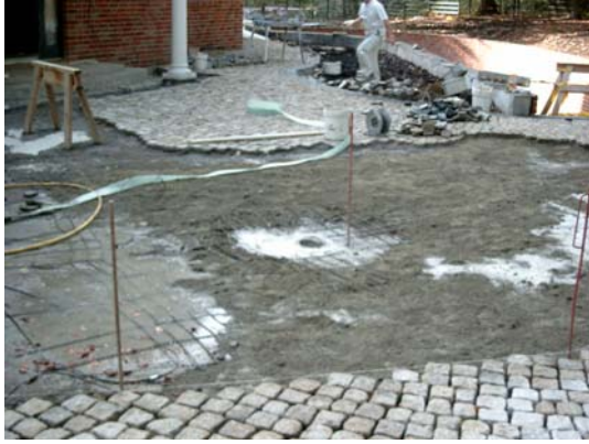
Bildzeile: Die Heizschlangen erstrecken sich bis zum Vorplatz des Hauses
