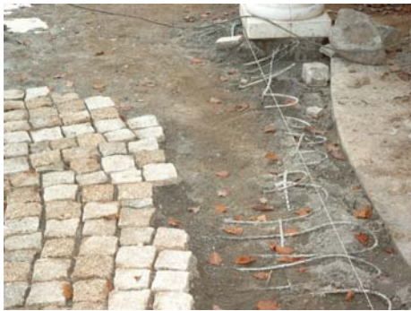
Bildzeile: Die Heizschlangen erstrecken sich bis zum Vorplatz des Hauses
