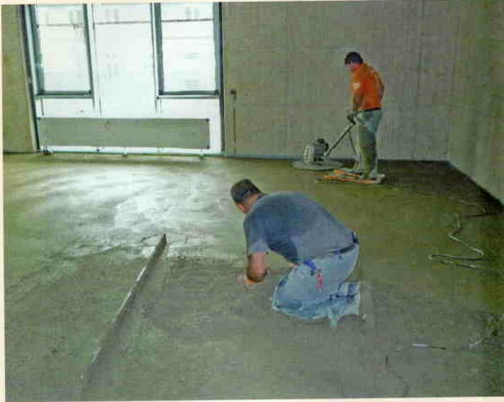
2 Eine Flügelglätte sorgt für eine dichte, feste und glatte Oberfläche des aufgetragenen Estrichs mit Estrich-Schnellbindemittel.
