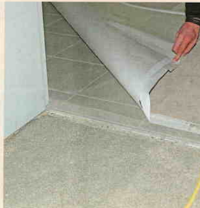
5 Eine Epoxidharz-Schicht schützt den Estrich. Im Nachbarraum sind die Fliesen schon verlegt. (Fotos: Quick-mix)
