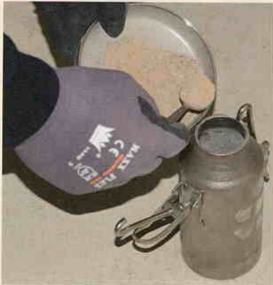
4 Mittels CM-Messung wird die Restfeuchte des Estrichs überprüft.
