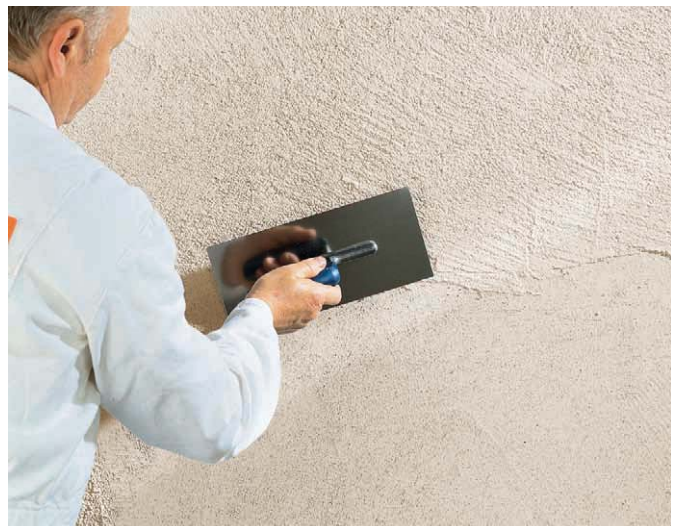
Als Oberputz diente ein mineralischer Scheibenputz.
