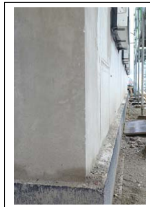
Bildzeile: Übergangsloser Sockelbereich: Auf Wunsch des Denkmalschutzes reicht die Putzfassade bis zum Boden. Für eine höhere Stoßfestigkeit wurde dieser Bereich durch Einsatz des extrem reißfesten quick-mix Panzergewebes PGP verstärkt.
