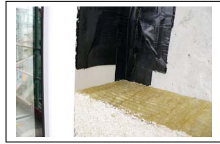
Bildzeile: Millimeterarbeit: Passgenau schließen sich die Mineralwolldämmplatten an das Laibungsbrett an.
