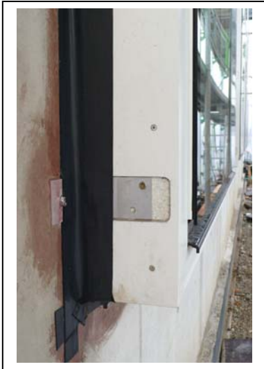
Bildzeile: Vorgesetzte Montage: Die Stufenglasfenster werden mit Laibungsbrettern auf das äußere Mauerwerk aufgesetzt. Halterungen und Winkel verschwinden dabei geschickt in der Holzkonstruktion.
