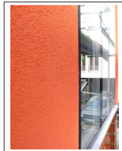
Bildzeile: Perfekte Harmonie: Flächenbündig bilden die LOBATHERM Wärmedämmplatten mit den Stufenglasfenstern eine optisch klare Linie.
