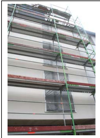
Bildzeile: Vorgesetzte Montage: Die Stufenglasfenster werden mit Laibungsbrettern auf das äußere Mauerwerk aufgesetzt. Halterungen und Winkel verschwinden dabei geschickt in der Holzkonstruktion.
