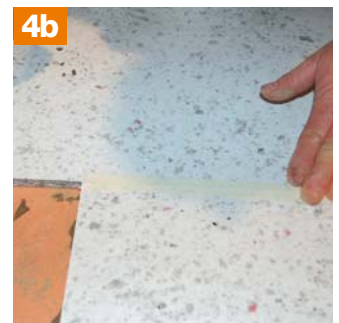
4b Entkopplungsplatte im Verbund versetzt verlegen und ggf. Fugen abkleben.
