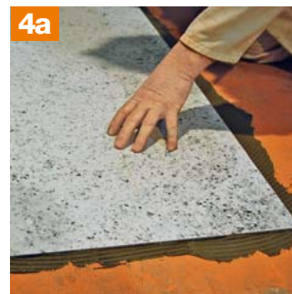
4a Entkopplungsplatte in das frische Kleberbett verlegen und anklopfen.
