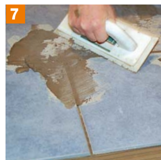
7 Verfugung der erstellten Beläge.
