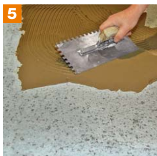
5 Nach Trocknung, quick-mix Flexkleber auf Entkopplungsplatte auftragen.
