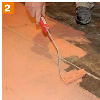
2 Voranstrich mit UG oder QG je nach Anwendungsfall auftragen
