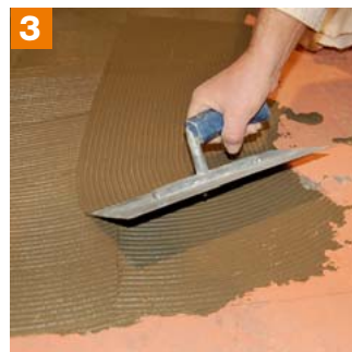
3 quick-mix Flexkleber auftragen
