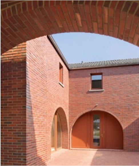
▲ Vier Rundbogenpaare fassen den Innenhof.
