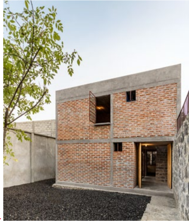
Der Ziegelkörper fungiert zum Innenhof hin als Sichtschutz. ▶
