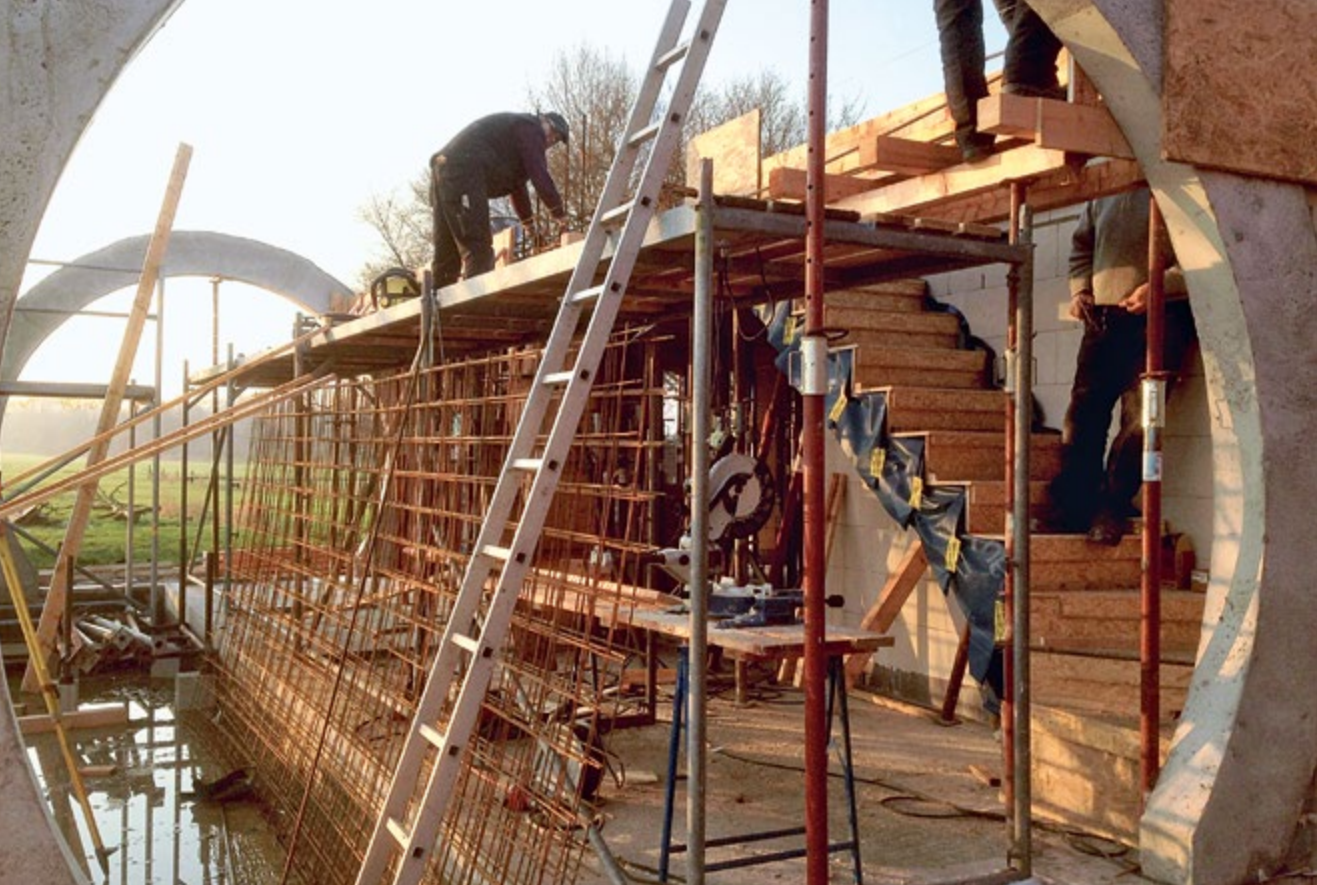
▲ Die Schalung und Betonierung des Bogens erfolgten vor Ort.
